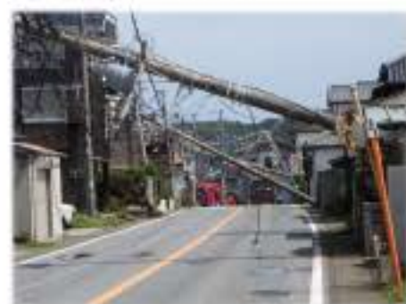
令和元年台風で倒壊した電柱 （館山市船形）
