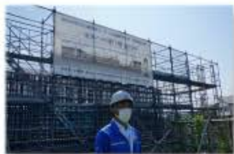
橋脚工事中の藤崎茜浜線を視察
