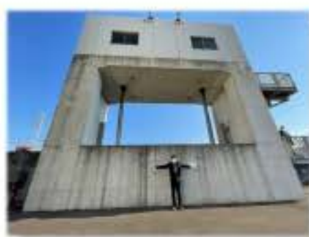
市川市高谷川水門を視察
