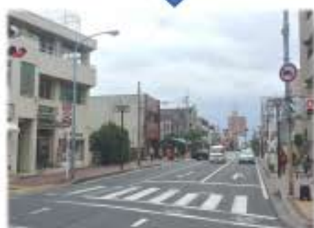
無電柱化整備後 （現在の実初商店街）
