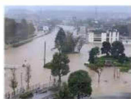
令和元年台風で浸水被害にあった茂原市役所
