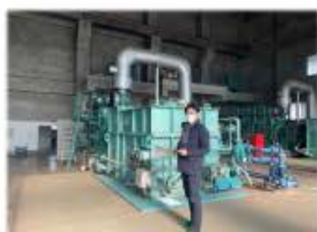
船橋市海老川排水機場を視察
